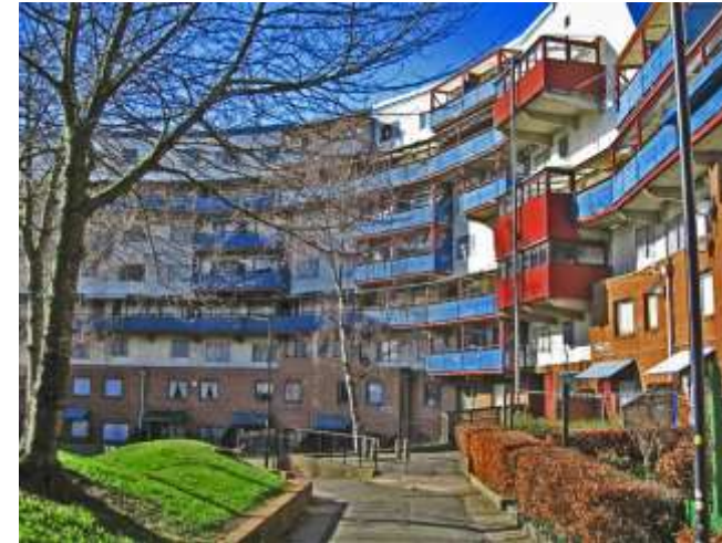
Byker Wall, Newcastle, Arkkite. Ralph Erskine
